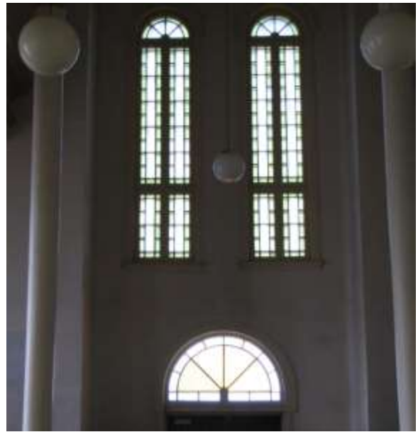
Fenêtres au-dessus de l'entrée principale
