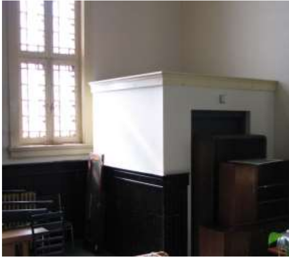
Entrée de l'ascenseur – côté sud
