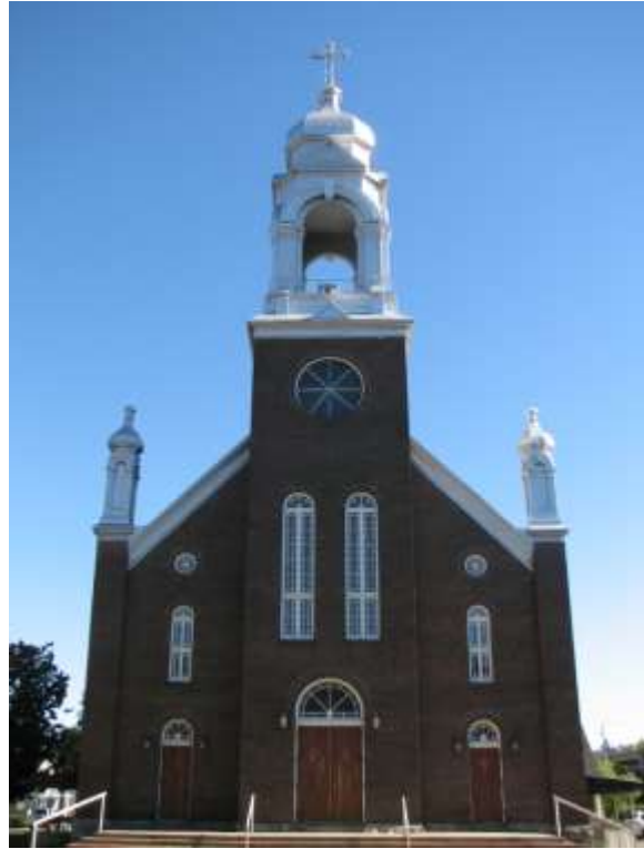
Côté ouest – rue St-Charles
